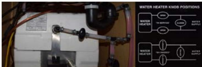
Système à 3 soupapes de dérivation
