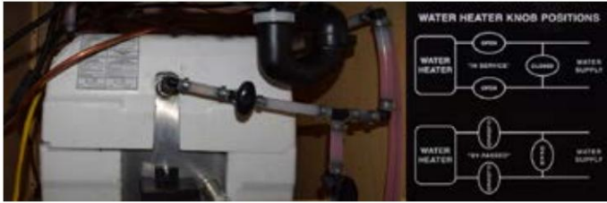
Système à 3 soupapes de dérivation
