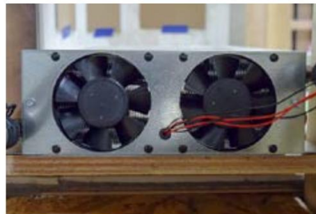
Ventilateur double Oasis sur l'échangeur de chaleur du sous-sol
