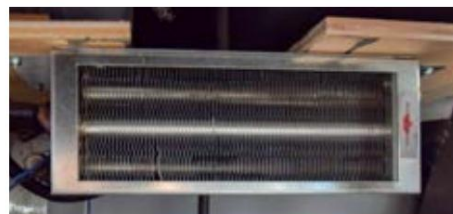
Échangeur de chaleur du sous-sol Oasis
