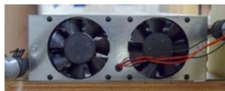
Ventilateur double Oasis sur le chauffage du sous-sol Echangeur
