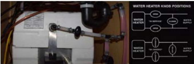
Système à 3 soupapes de dérivation
