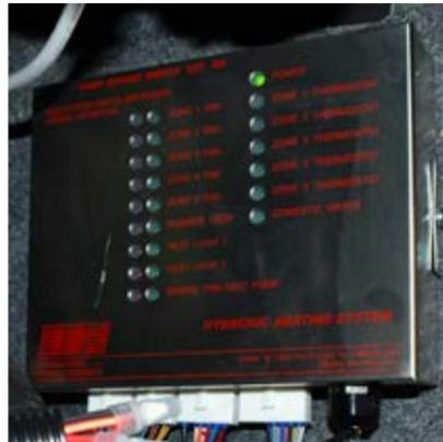
Le tableau de commande de zone (Figure 8-5) contient sept DEL vertes pour l'alimentation, les thermostats des zones 1, 2, 3, 4 et 5 et l'eau potable.
