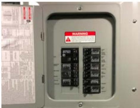
Les disjoncteurs peuvent être réinitialisés en basculant simplement le disjoncteur en position « off », puis en le remettant en position « on » une fois la condition de surcharge supprimée. Tous les disjoncteurs de 120 volts sont situés dans le panneau de service principal à moins que l'autocar ne soit équipé d'un onduleur/chargeur.
