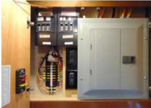
Exemple de panneau de fusibles à pousoir diesel
